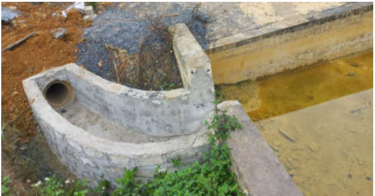
Hình 3.5. Ống,rãnh thu nước chảy vào bể lắng
