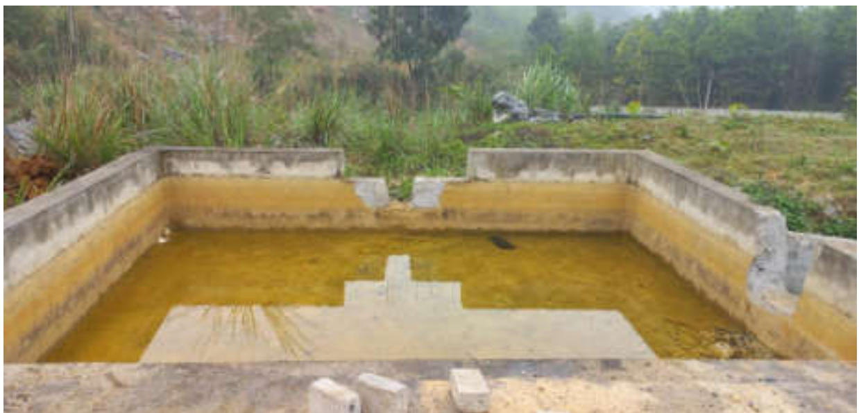
Hình 3.5. Ống,rãnh thu nước chảy vào bể lắng
